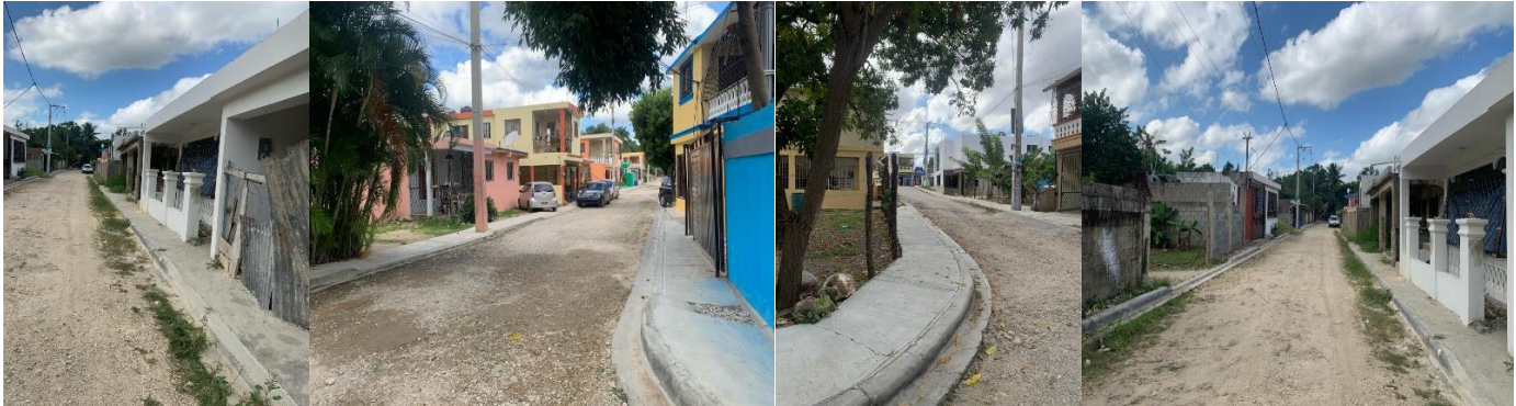
2. Construcción de Aceras y Contenes, Sabana Toro.
