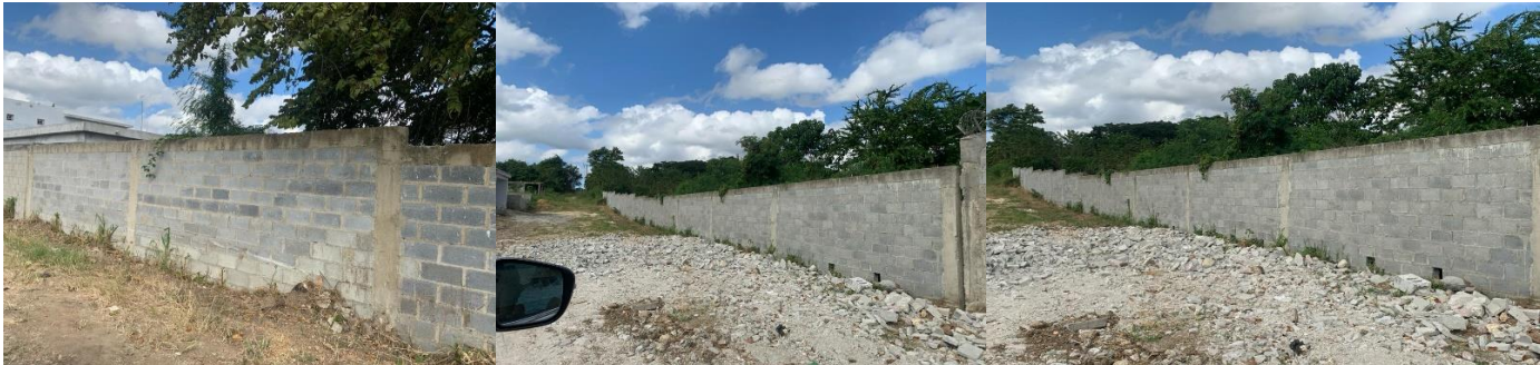
3. Construcción de Pared Perimetral, José Francisco Peña Gómez 1.
