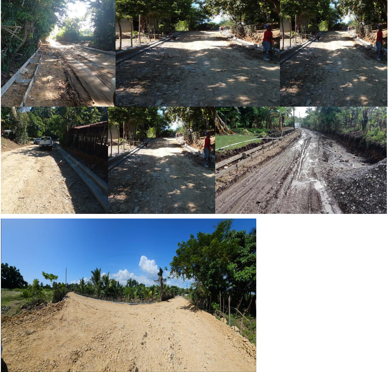
.Completivo Aceras y Contenes Nuevo Cementerio Municipal, Los Melitones Ingenio Nuevo.
